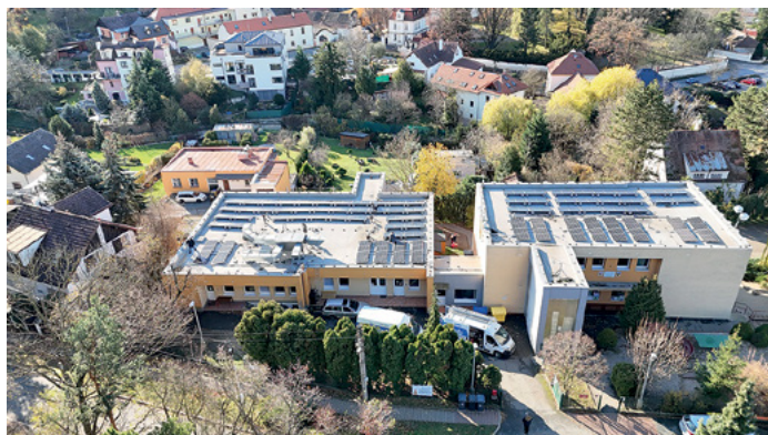
▲ Fotovoltaická elektrárna na I. stupni školy o výkonu 43,45 kWp již byla dokončena a vyrábí elektřinu.
